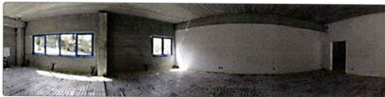
FIG. 5 Pavimento radiante (Velta)
